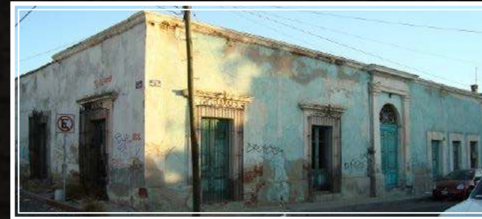
Estado en el que recibimos el edificio. (2018)
